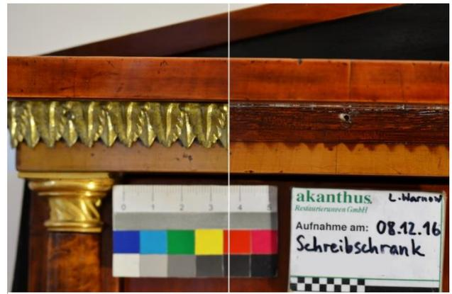
Abb. 6: Detail links: entfärbte Harz-Politur unterhalb der Messing-Zierleiste, Aufsatz Schreibtisch um 1810. Detail rechts: Rotpolitur unter abgenommener Messinggussleiste, Aufsatz Schreibtisch um 1810.
