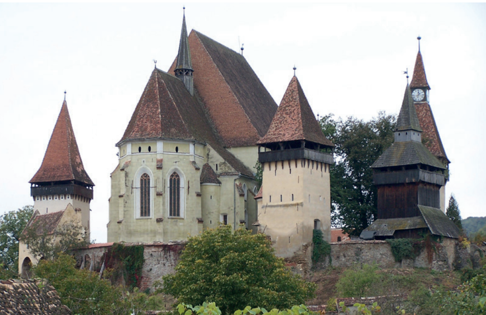
Abb. 1: Nordostansicht des Kirchenburgenensembles mit Mausoleumsturm rechts vom Chor der Kirche
