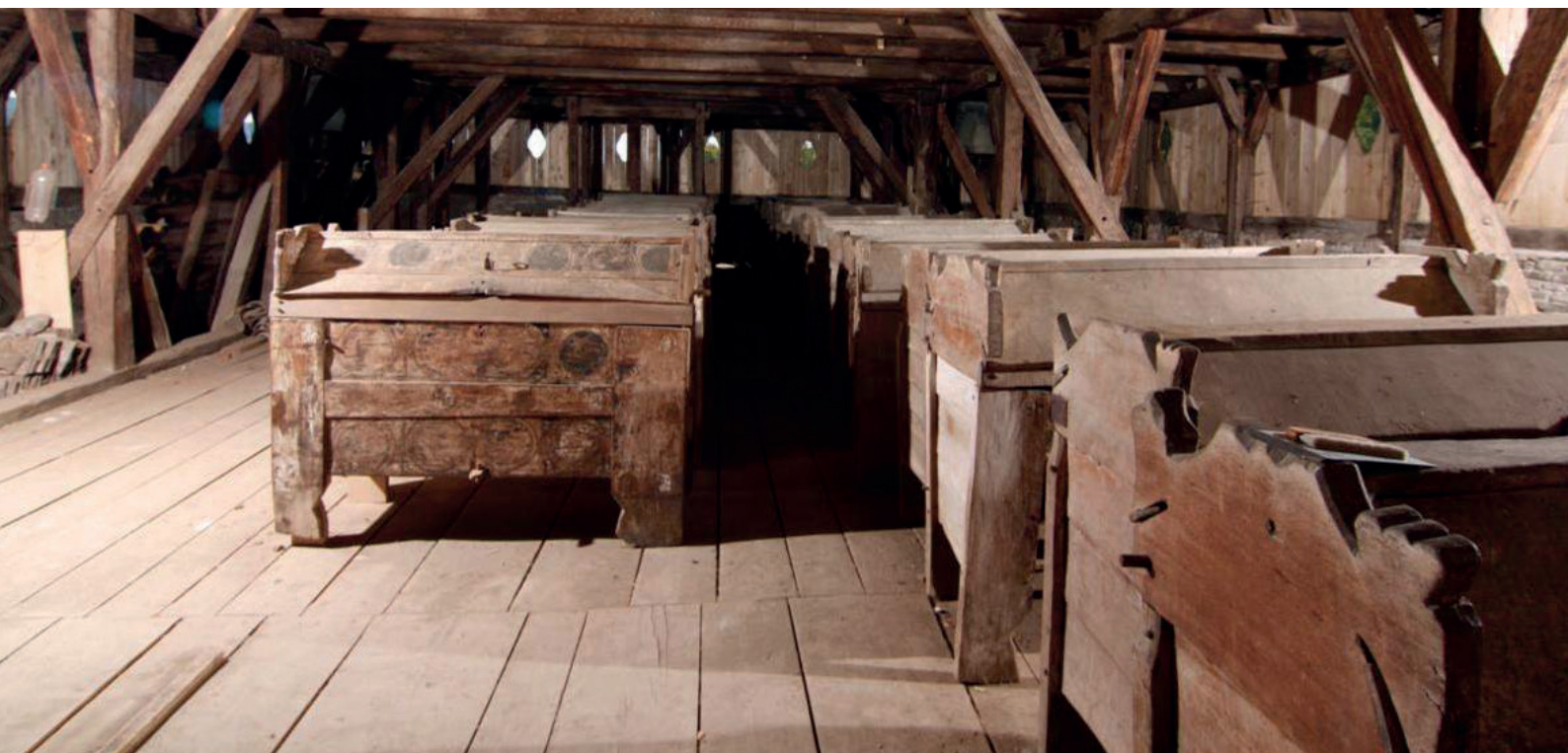
Abb. 5: Der Henndorfer Dachboden heute.
