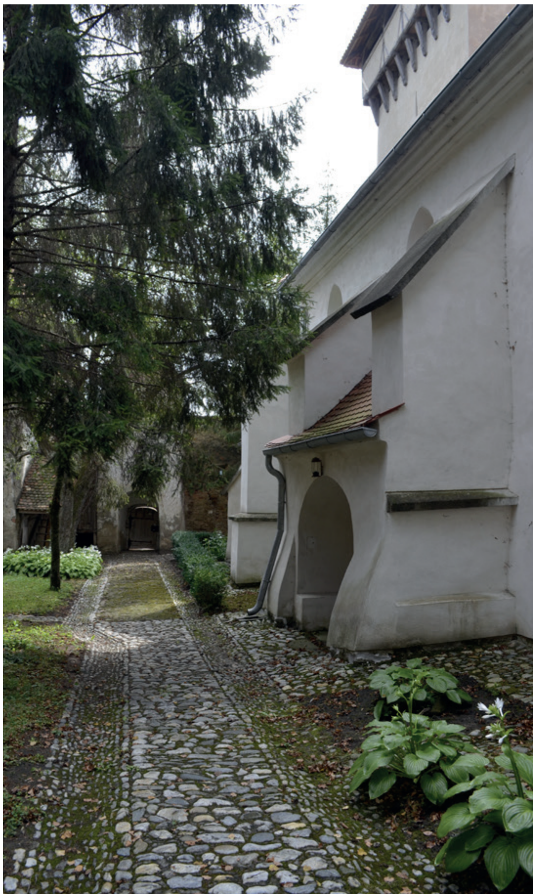
Abb. 2: Schönberg, Kirchenburg, Wasserablaufsystem
