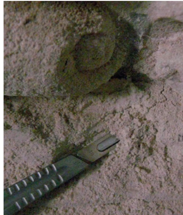
Abb. 14: Gefügezerfall am Epitaph des Bischof Mathias Schiffbaumer
