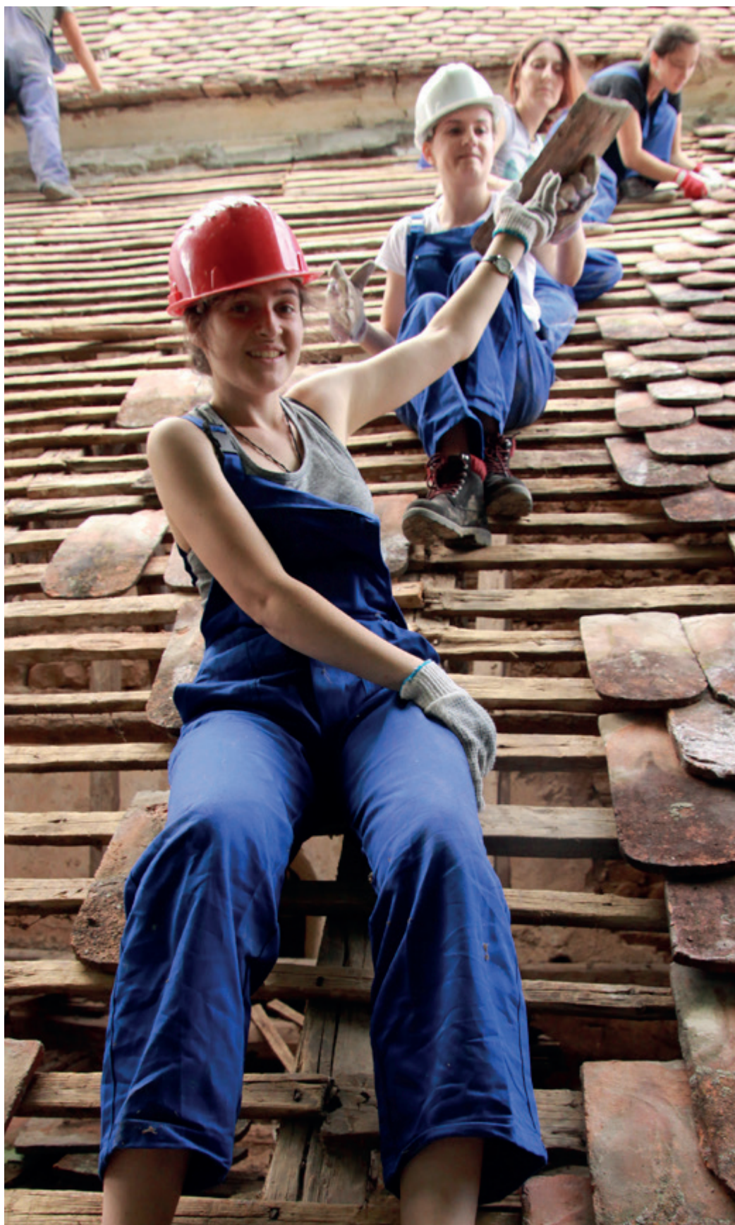
Fig. 2: Voluntari în timpul unei intervenții de punere în siguranță a acoperișului bisericii evanghelice fortificate din Alțina, județul Sibiu. S-au refolosit țiglele istorice aflate în stare bună și s-au completat cele degradate cu unele noi, confecționate manual în tehnica tradițională.
