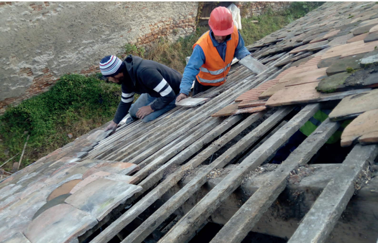
Abb. 1: Kirchenburg Arbegen/ Agârbiciu: Dacharbeiten im Laufe des Jahres 2018
