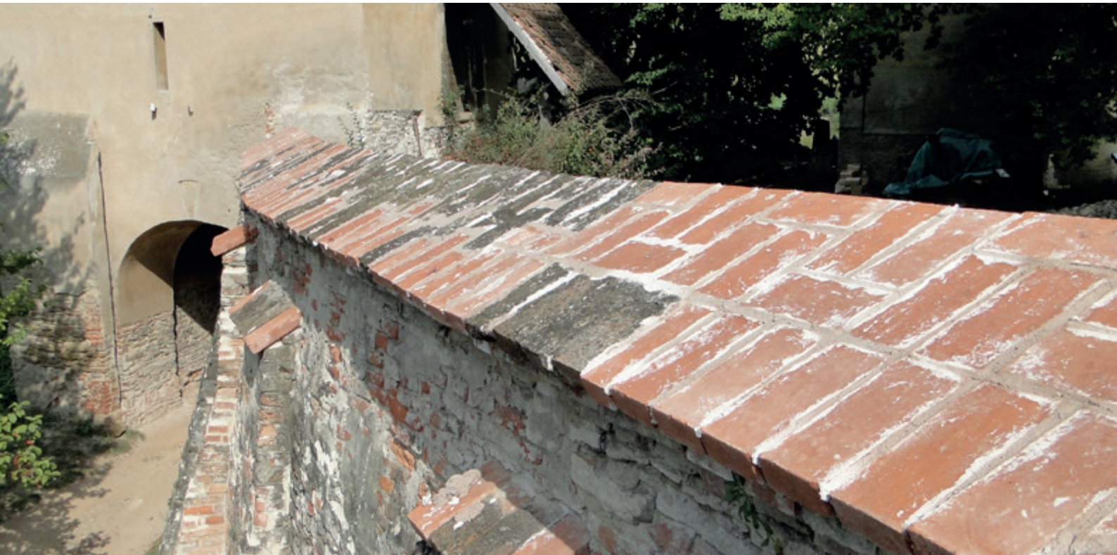
Abb. 5: Restaurierte Mauerkrone aus handgemachten Mauerziegeln gleichen Formates wie original. Intakte originale Teilflächen sind erhalten geblieben.
