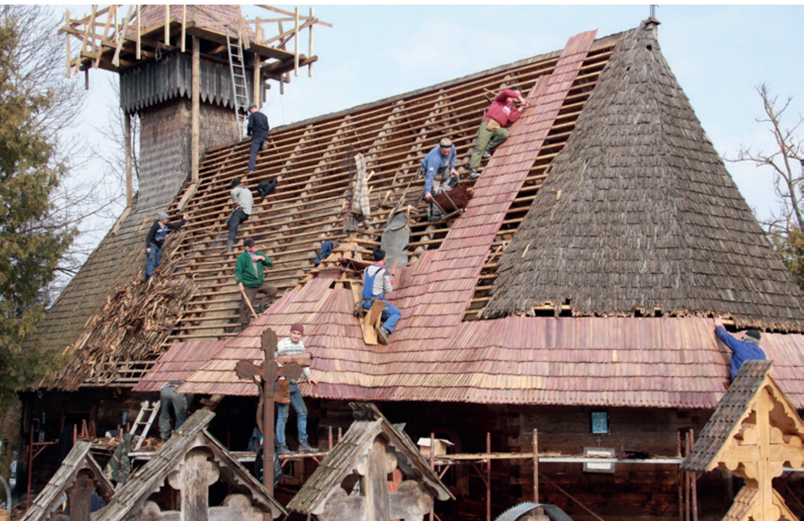
Fig. 3: Intervenție realizată la biserica ortodoxă din lemn (secolele XVI – XIX) din satul Breb, comuna Ocna Șugatag, județul Maramureș, pentru schimbarea învelitorii. Meșterii dranițari din comunitate au confecționat local materialul, iar bărbații din comunitate au montat-o, cu ajutorul voluntarilor, pe acoperiș, după ce a fost tratată în prealabil cu o soluție hidrofoabă, antiseptică și împotriva atacurilor xilofage. Femeile din localitate au gătit pentru voluntari, iar proprietarii de pensiuni au oferit cazare gratuită.
