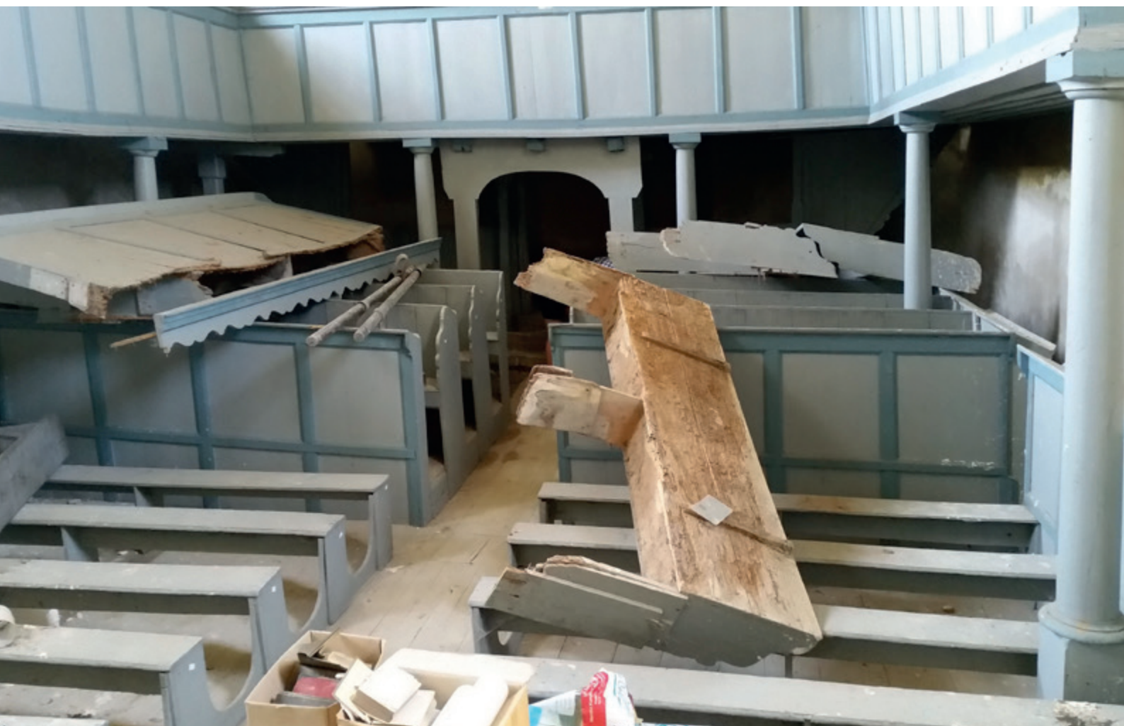
Abb1: Die wehrlose Holzausstattung, hier in Abtsdorf.
