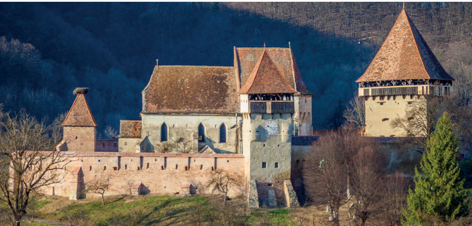
Abb. / Fig. 7+8: Almen / Alma Vii, vor – und nach der Restaurierung / înainte și după restaurarea (Foto: Mihai Eminescu Trust (MET))
