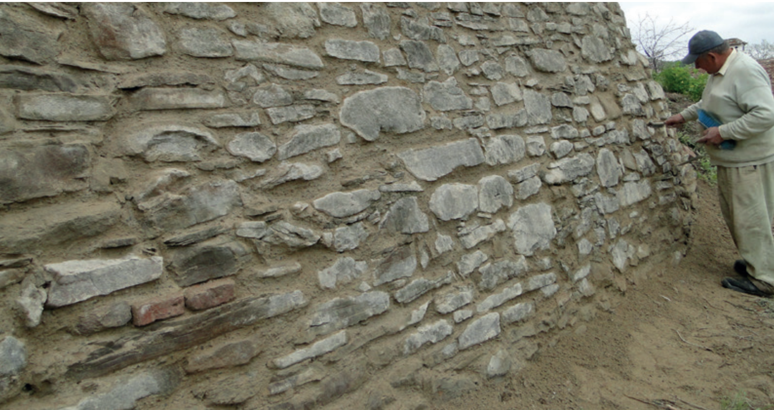
Abb. 4: Restaurierte Mauerfläche: Die Oberflächenbeschaffenheit ist in ihren physikalischen und chemischen Eigenschaften erhalten geblieben.
