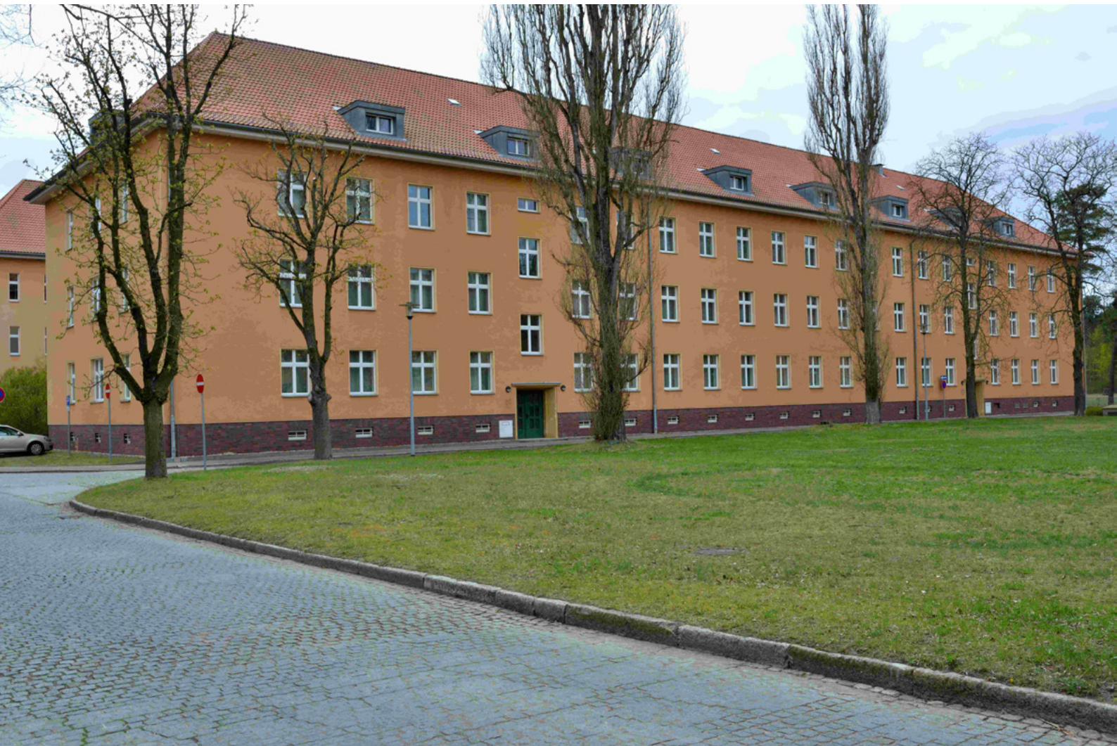
Typische „Heereskaserne“ in Zossen, Ortsteil Wünsdorf. Foto: Stefan Brather, BLDAM.
