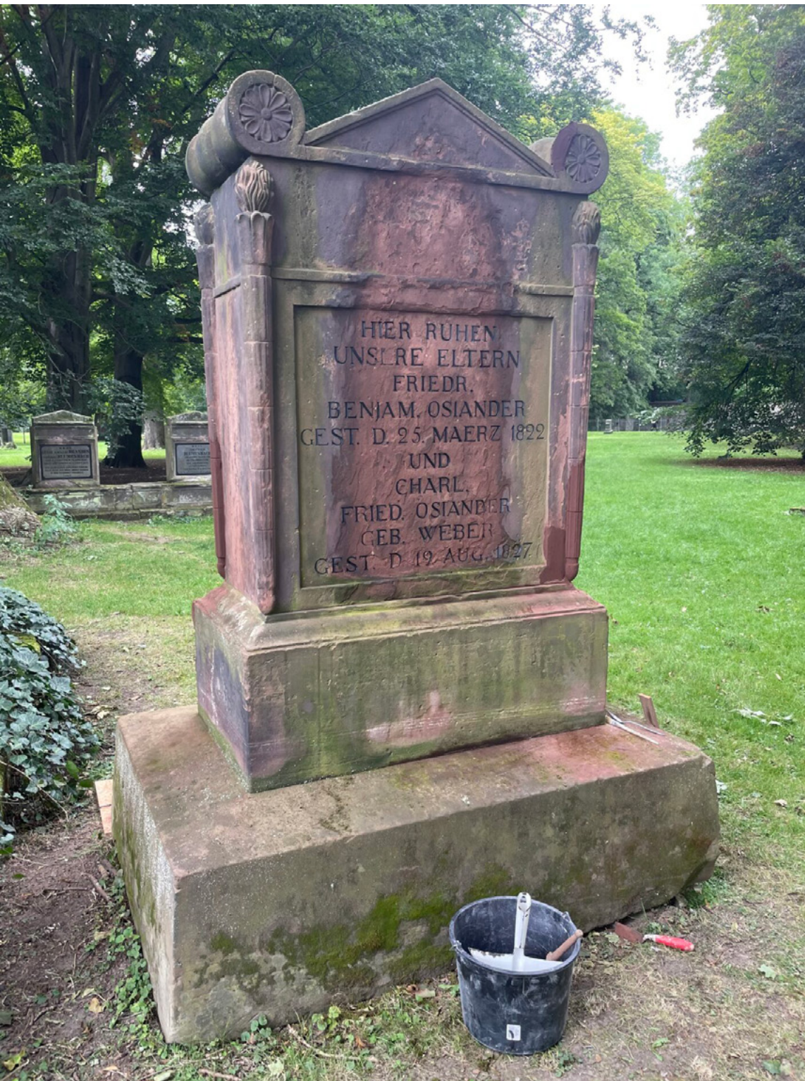
Klassizistisches Grabdenkmal mit formergänzenden Antragungen aus Heißkalkreaktionsmörtel. Foto: Wanja Wedekind, 2021.
